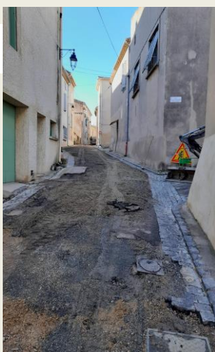
Pendant les travaux
